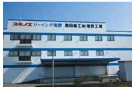
会社・工場外壁
